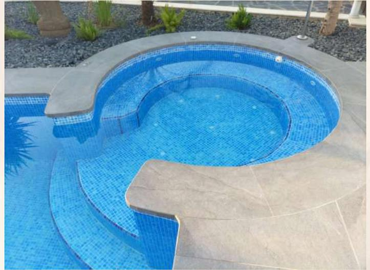
pavimento utilizado de 90x90 cms adz, sacamos plantillas de todas las partes curvas incluida la zona del jacuzzi, y luego realizamos ingletes manualmente para darle la forma.
