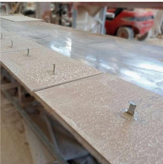
Todas las piezas del techo fueron preparadas con garras de anclaje metálicas y resina especial para que quedasen ancladas mecánicamente
